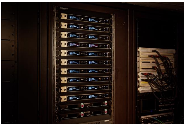
Die neuen Sennheiser EM 6000 Doppellempfänger sind im Hessischen Staatstheater Wiesbaden über ihre AES/EBU-Ausgänge verlustfrei mit einem digitalen Mischpultsystem verbunden
